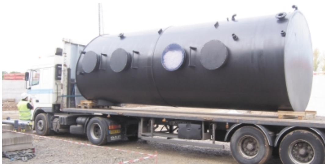
Arrivée d'une tour de désodorisation
